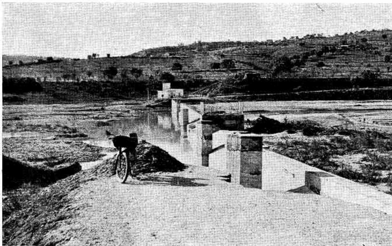
Fig. 21 — Opera di presa sul F. Sinni danneggiata dalla piena del 24-25 novembre 1959. Si nota l'esportazione del rilevato in terra e lo scalzamento delle opere murarie.
